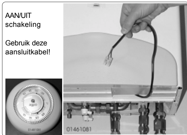
Figuur 13. Aansluitkabel voor een AAN/UIT schakeling
