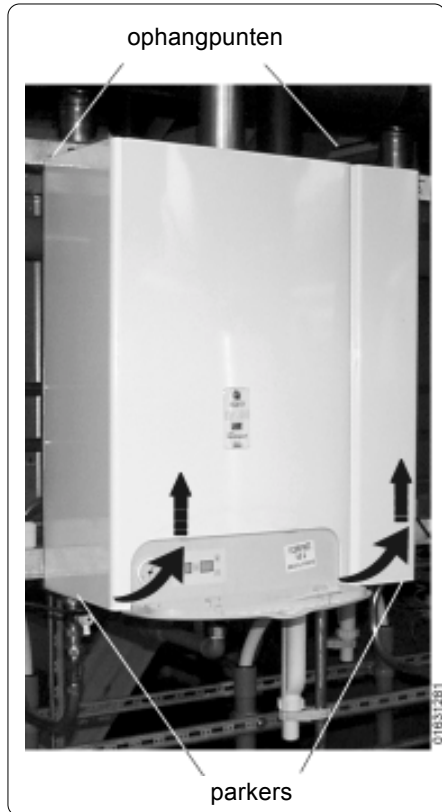
Figuur 17. Het verwijderen van de mantel
