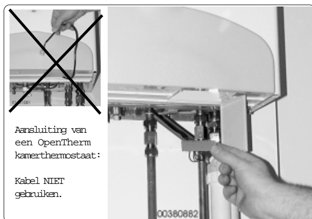
Figuur 14. De plaats van de toestelconnector
