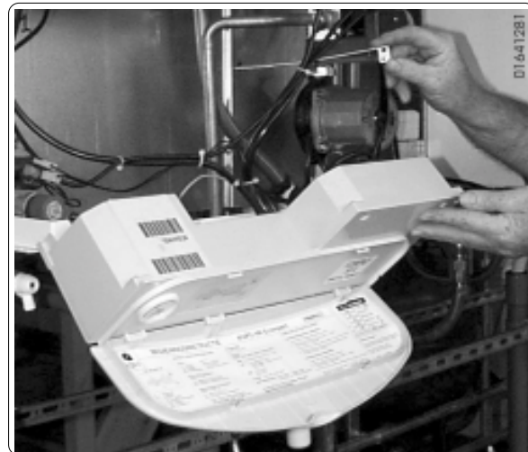
Figuur 21. Het naar voren kantelen van de elektrakast
