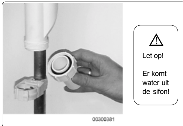
Figuur 4. De vuil-opvangbeker onder de toestel sifon.
