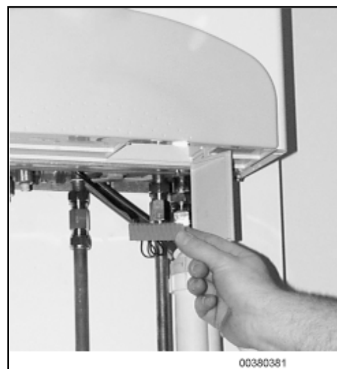
Figuur 8. De plaats van de externe connector onder het toestel
