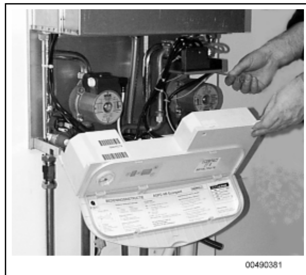
Figuur 25. Het naar voren kantelen van de elektrakast.
