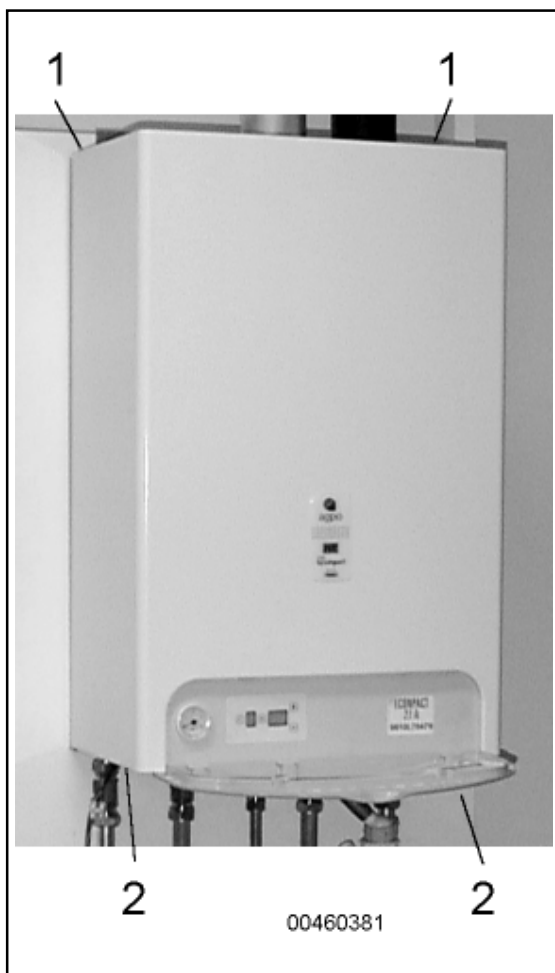
Figuur 24. Het verwijderen van de mantel.
