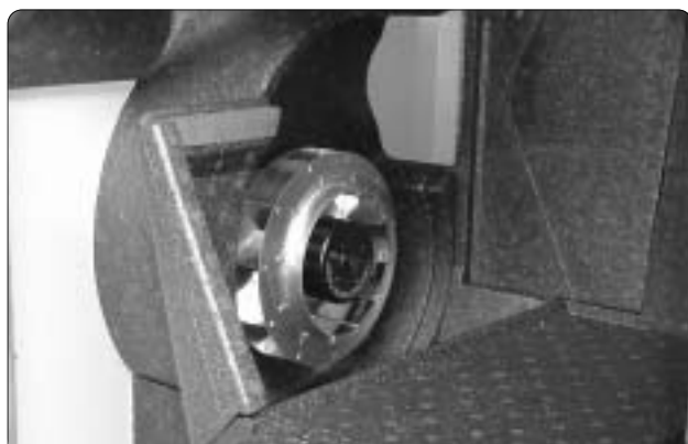
Figuur 15-7. Reinigen van de ventilatorwaaier.
