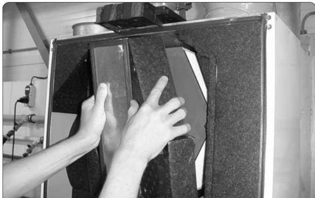
Figuur 14.3 Verwijderen bypass.
